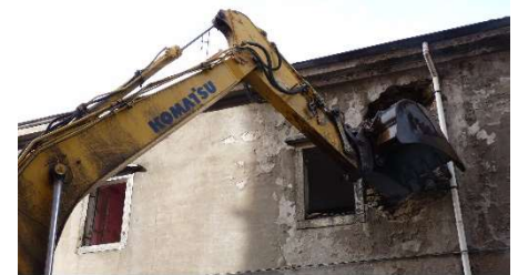
3 aprile 2024 - inizia la demolizione dell'ex Pavan (redazione)
